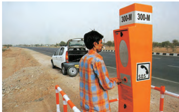
चित्र 7.10 – राष्ट्रीय राजमार्ग-8 पर एक आपातकालीन कॉल बॉक्स
